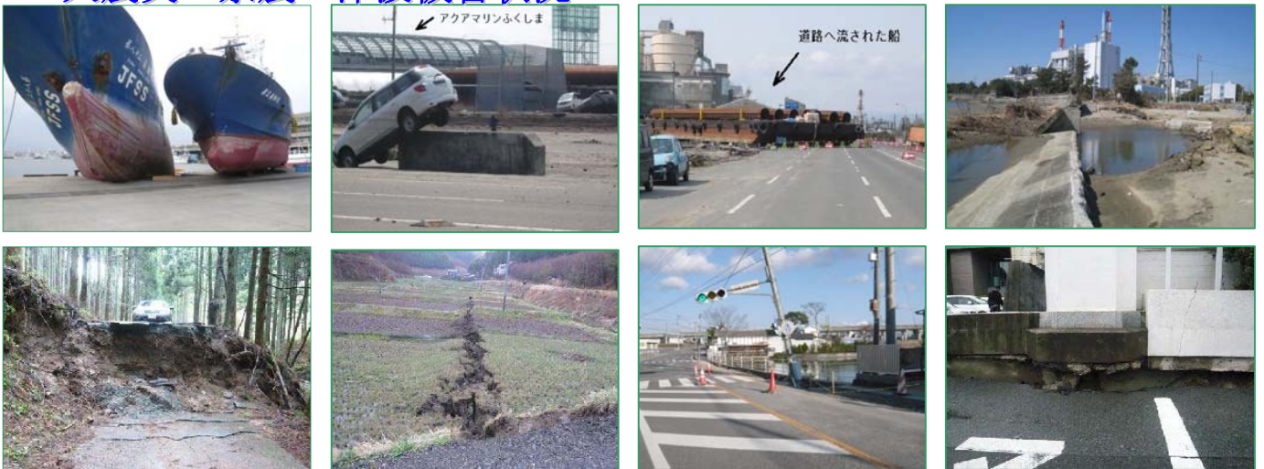
【大地震により引き起こされた大津波による甚大な被害】 小名浜港・田人・いわき市内
