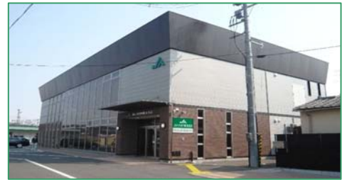
【外観状況】コロンプス工法を採用
