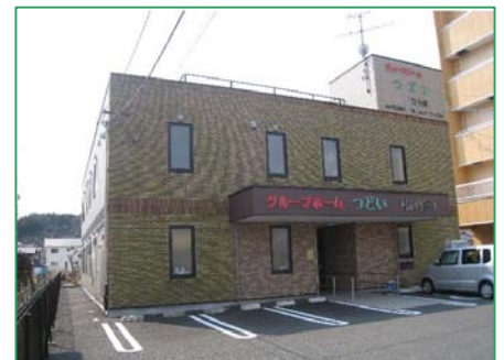
【外観状況】コロンプス工法を採用
