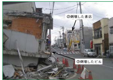
③ 【倒壊した書店とビル】
