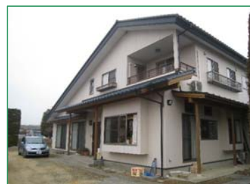
【外観状況】コロンプス工法を採用
