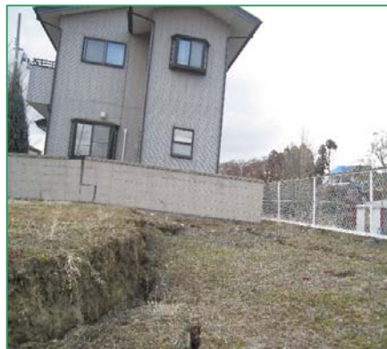
② 【擁壁が崩壊し建物が不同沈下】
