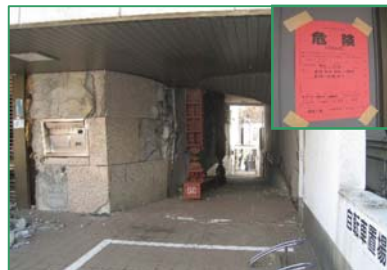
⑥ 【倒壊防止のため、ジャッキ補強】
