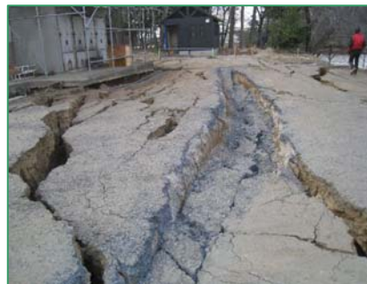
① 【液状化により道路が波打ち・建物は沈下】
