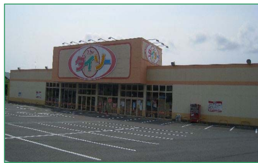
【外観状況】コロンプス工法を採用
