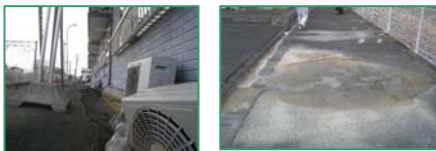
① 【液状化により道路が波打ち・建物は沈下】
