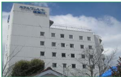
④ 【倒壊したホテル 構造クラック】
