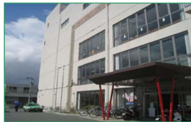
⑤ 【危険判定の福祉ビル】
