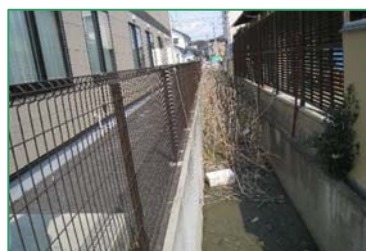
・擁壁へ土圧軽減のジオフォームを採用
